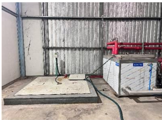
รูปที่ 3.2-35 ภาพของบ่อรวบรวมสารละลายโครเมียม จากชุดอุปกรณ์ชุบเคลือบลูกรีดเพื่อการซ่อมบำรุง
