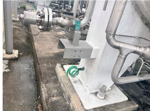
รูปที่ 3.2-69 อุปกรณ์กักเก็บและลำเลียง ต่อเข้ากับระบบสายดิน
