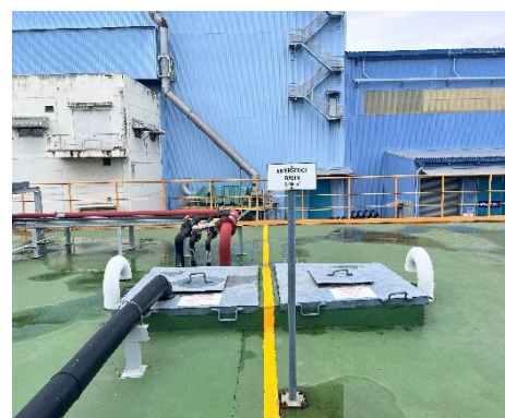
รูปที่ 3-12 บ่อพักน้ำทิ้งฉุกเฉิน
