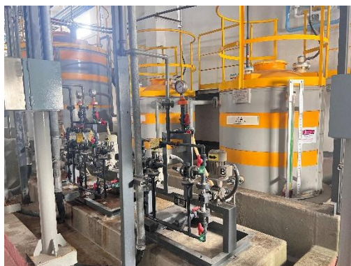
รูปที่ 3.2-64 การออกแบบให้หน่วยที่มี การใช้สารเคมีเป็นระบบปิด
