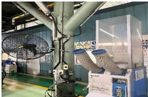
รูปที่ 3.2-51 เครื่องปรับอากาศและพัดลม บริเวณพื้นที่ทำงานที่มีอุณหภูมิสูง
