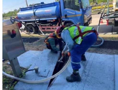
รูปที่ 3.2-14 การสูบลากตะกอนจาก ถังบำบัดน้ำเสียสำเร็จรูป
