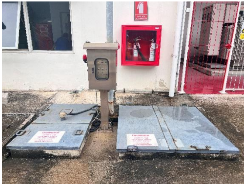
รูปที่ 3.2-13 ถังบำบัดน้ำเสียสำเร็จรูป
