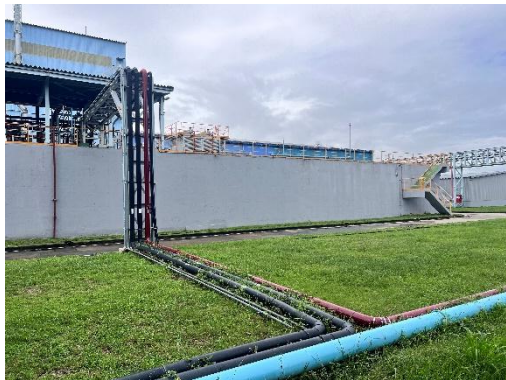
รูปที่ 3.2-23 ท่อระบายน้ำเสียและรางระบายน้ำฝนของโครงการ
