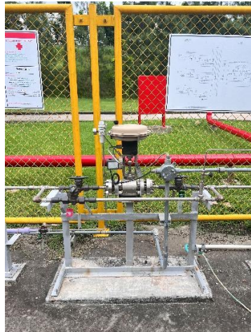
รูปที่ 3.2-70 อุปกรณ์ป้องกันก๊าซไหลกลับในท่อ (Check Valve)
