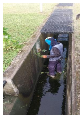
รูปที่ 3.2-27 การขุดลอกรางระบายน้ำ
