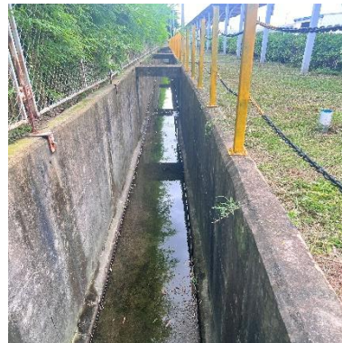
รูปที่ 3.2-23 ท่อระบายน้ำเสียและรางระบายน้ำฝนของโครงการ
