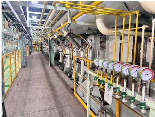
รูปที่ 3.2-1 ระบบ Low NO x Burner ที่ปล่อง Annealing Furnace
